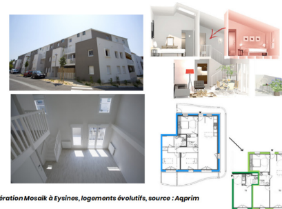
Opération Mosaik à Eysines, logements évolutifs, source : Agprim
